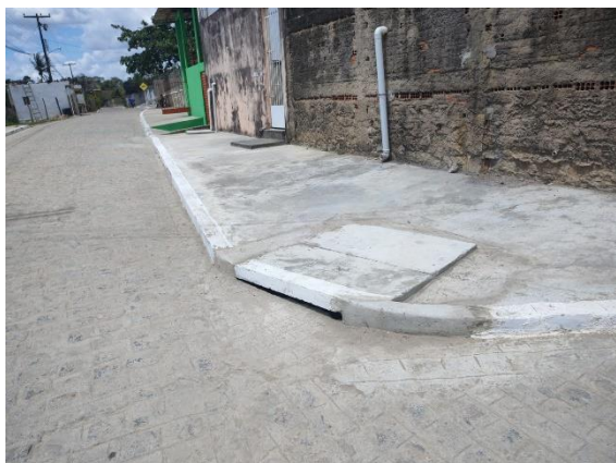
FOTO 7: Pavimentação em paral. Graníticos - Rua 01 / Drenagem
