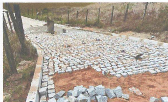
FOTO 4: Rua 01 – Pavimentação em paralelepípedos
