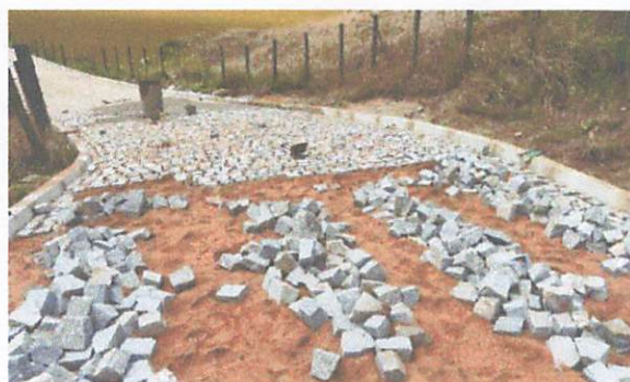
FOTO 5: Rua 01 – Pavimentação em paralelepípedos
