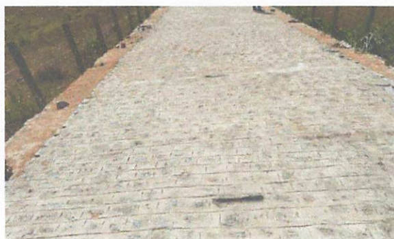
FOTO 3: Rua 01 – Pavimentação em paralelepípedos, trecho do Muro de contenção
