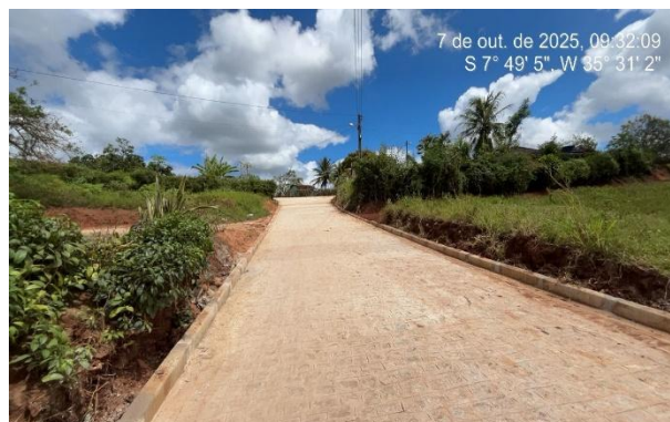
FOTO 4: Pavimentação em paralelepípedos no Sítio Bela Vista/Brejinhos.
