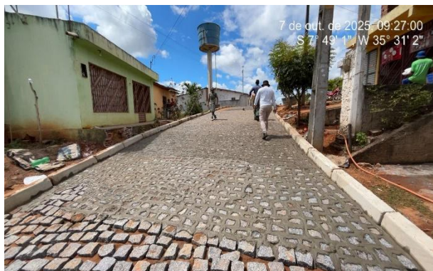
FOTO 7: Pavimentação em paralelepípedos no Sítio Bela Vista/Brejinhos.
