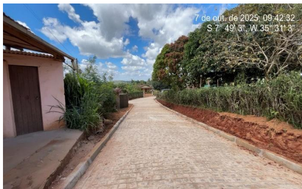
FOTO 1: Pavimentação em paralelepípedos no Sítio Bela Vista/Brejinhos.
