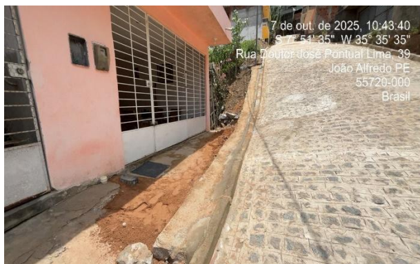
FOTO 23: Execução de canaleta em concreto simples.
