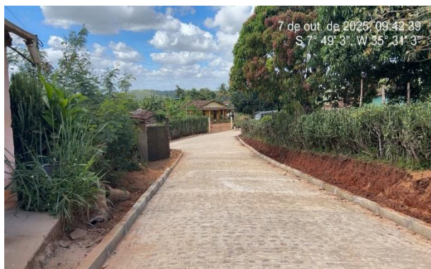
FOTO 3: Pavimentação em paralelepípedos no Sítio Bela Vista/Brejinhos.
