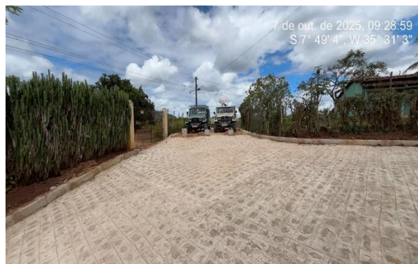
FOTO 6: Pavimentação em paralelepípedos no Sítio Bela Vista/Brejinhos.
