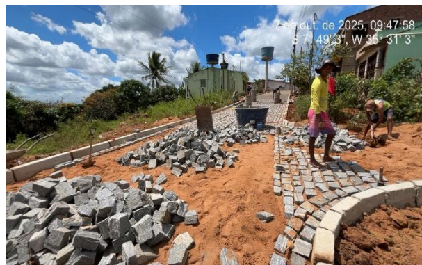
FOTO 8: Pavimentação em paralelepípedos no Sítio Bela Vista/Brejinhos.
