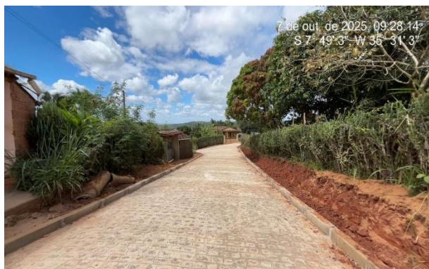
FOTO 5: Pavimentação em paralelepípedos no Sítio Bela Vista/Brejinhos.
