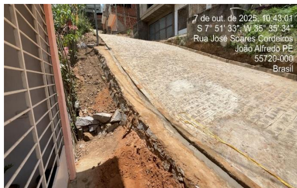
FOTO 24: Execução de muro de arrimo na Rua Humberto dos Prazeres.
